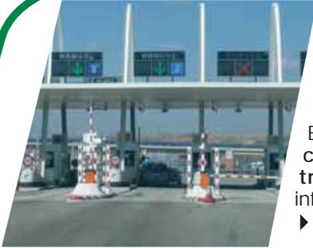
Para acceder a las distintas cabinas del puesto de control **suelen existir varios carriles, uno por cada cabina**, todos ellos regulados con un semáforo para cada carril.
